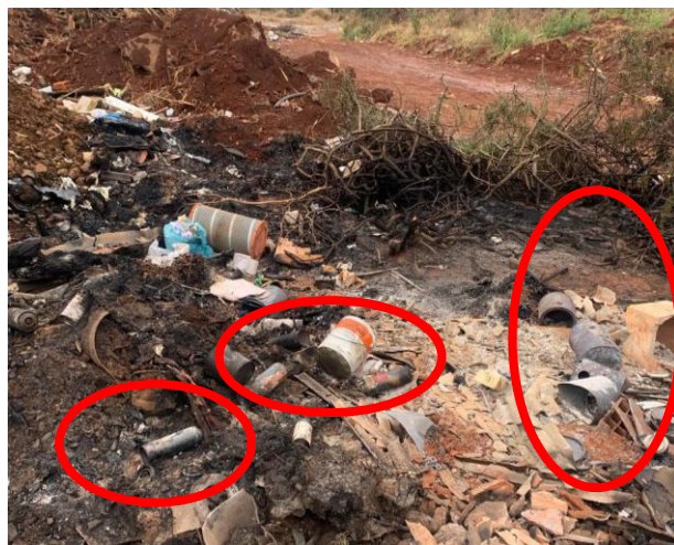
Figura 55 – Destinação inadequada de RCC (classe D)
