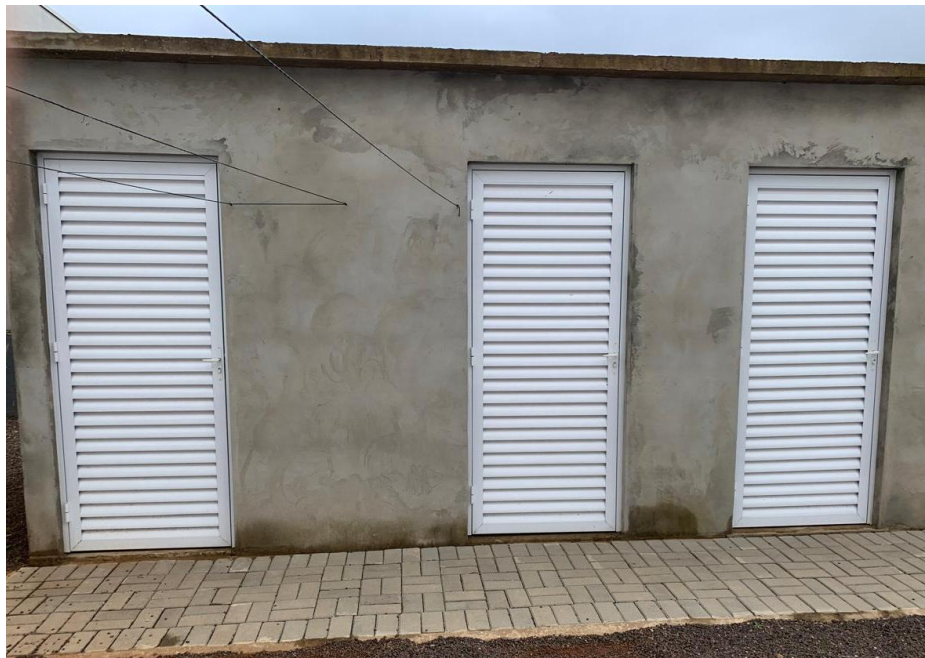
Figura 36 – Abrigo dos RSS da UBS Agnes Settle Addison Momesso
