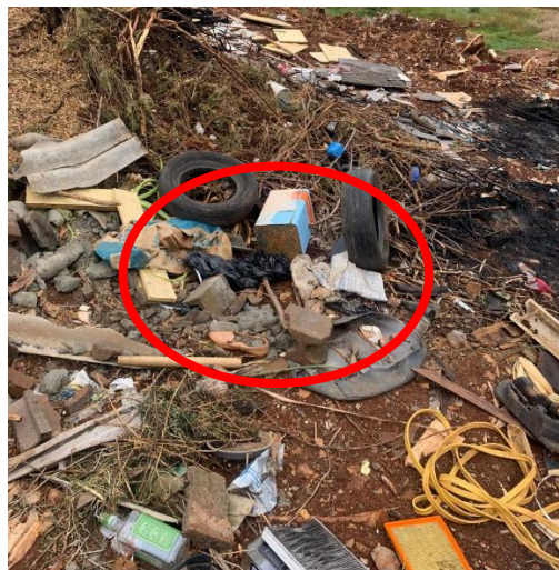
Figura 56 – Destinação inadequada de RCC (classe D)
