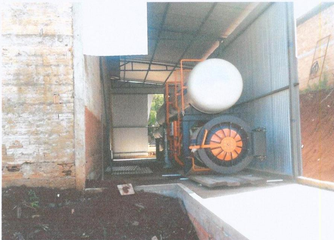
Figura 01. Usina de Tratamento de Madeira.
