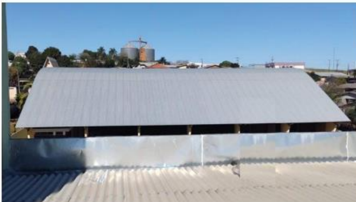
Telhado do Ginásio – Local da instalação
