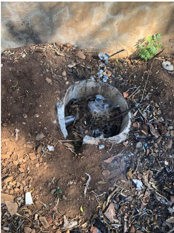
Fotos 27 á 30: PVs e ligações obstruídas.
