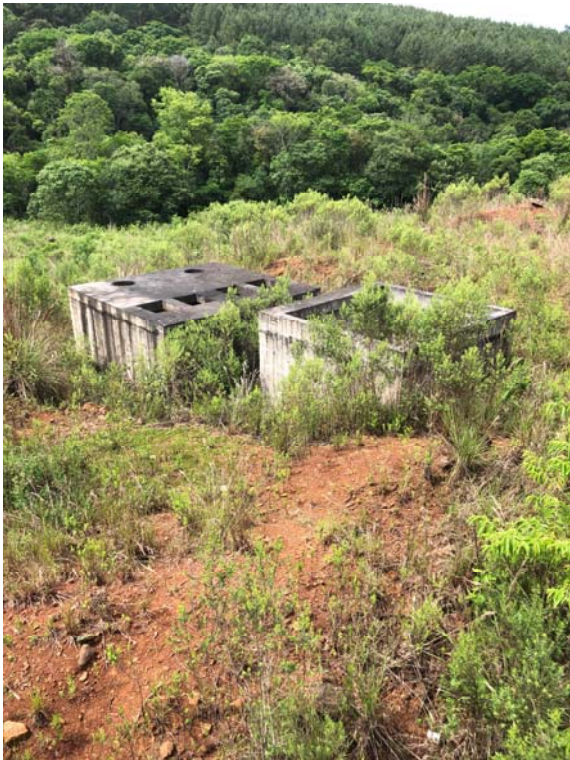
Fotos 15 á 18: Tanques de aeração, caixa de distribuição, elevatória de logo e tanques de contato.
