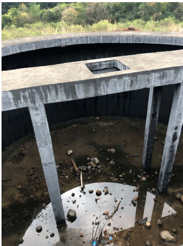
Fotos 69 a 71: Tanques de aeração - Ausência de materiais.
