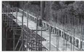
Comentários: Execução da armação do aço das vigas do reator UASB. Foto 03
