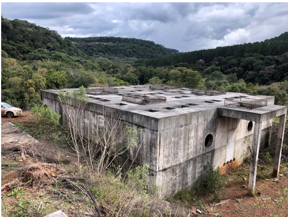
Fotos 64 a 66: Equalizador e Reator UASB.
