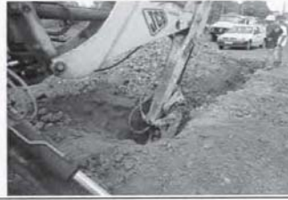
Comentários: Escavação mecânica em solo rochoso. Foto 2
