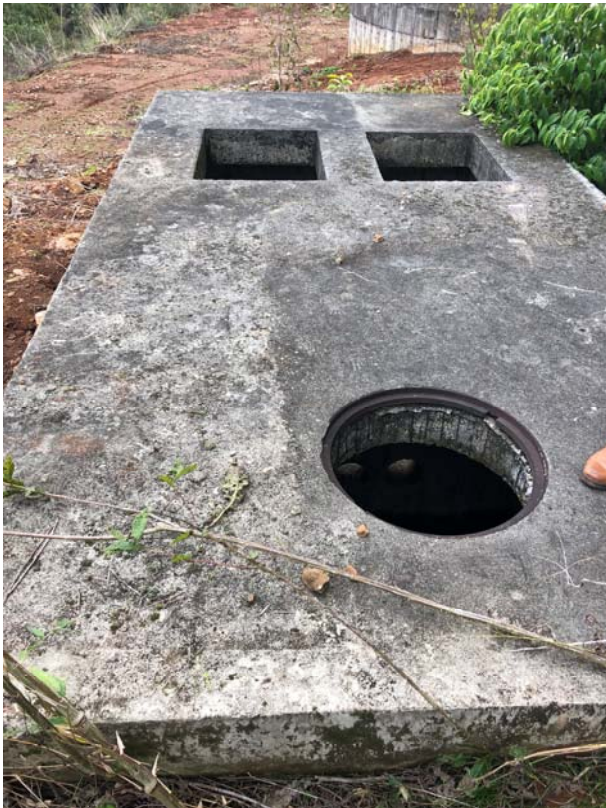
Fotos 72 a 75: Elevatórias de lodo e caixa de distribuição.
