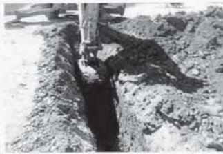
Comentários: Escavação mecânica em solo rochoso. Foto 1
