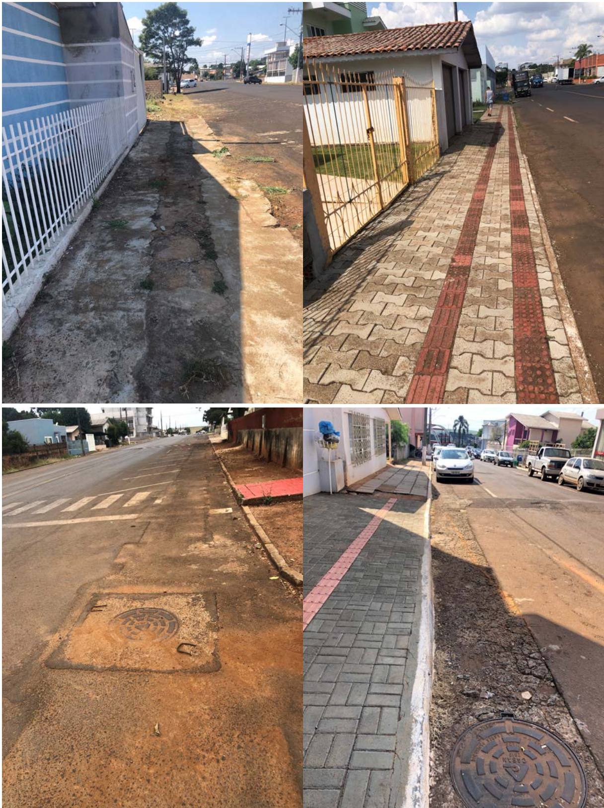
Fotos 39 á 42: Pavimentações
