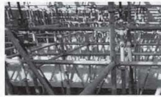
Comentários: Execução da armação do aço das vigas do reator UASB. Foto 04
