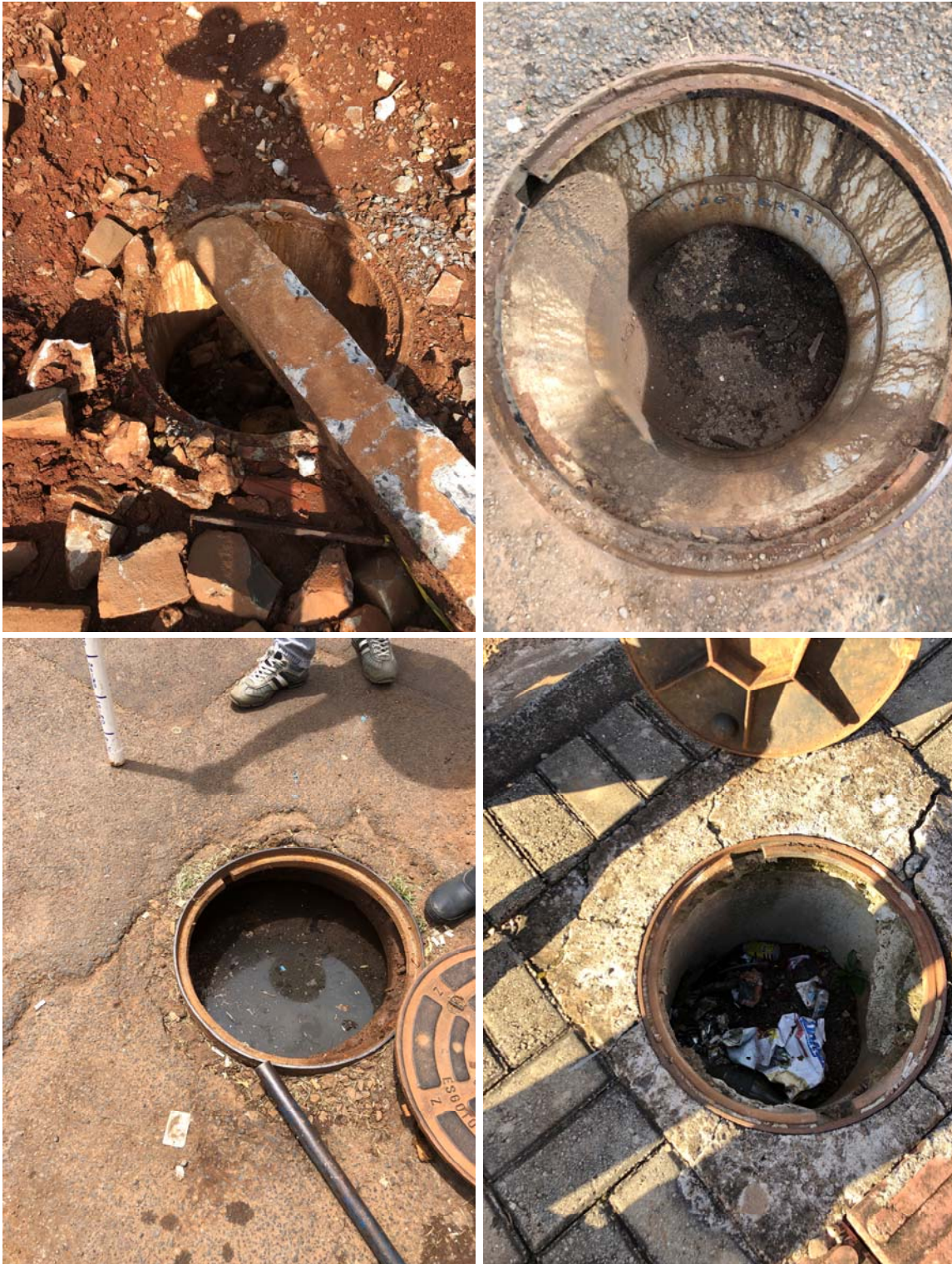
Fotos 31 á 34: PVs e ligações obstruídas.
