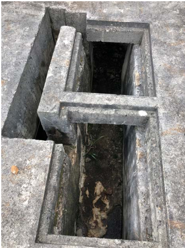
Fotos 60 a 63: Canal de entrada - Ausência de materiais.
