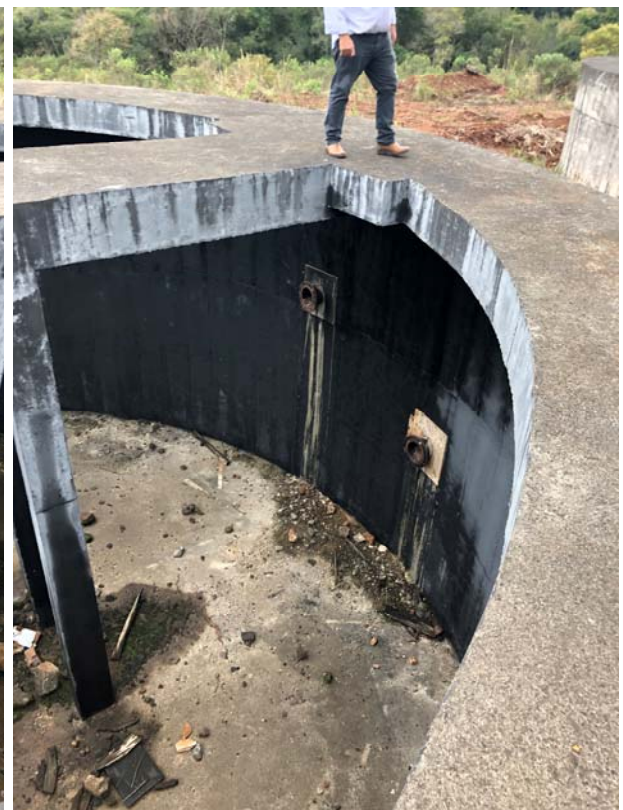
Fotos 69 a 71: Tanques de aeração - Ausência de materiais.
