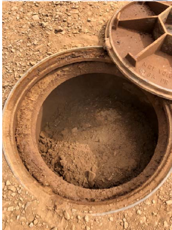
Fotos 03 á 06: Situação de alguns PV's - totalmente obstruídos.
