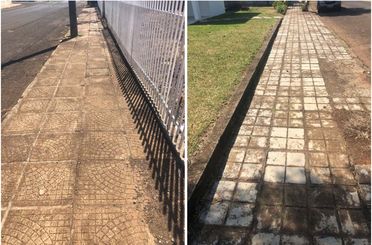
Fotos 37 á 38: Pavimentações
