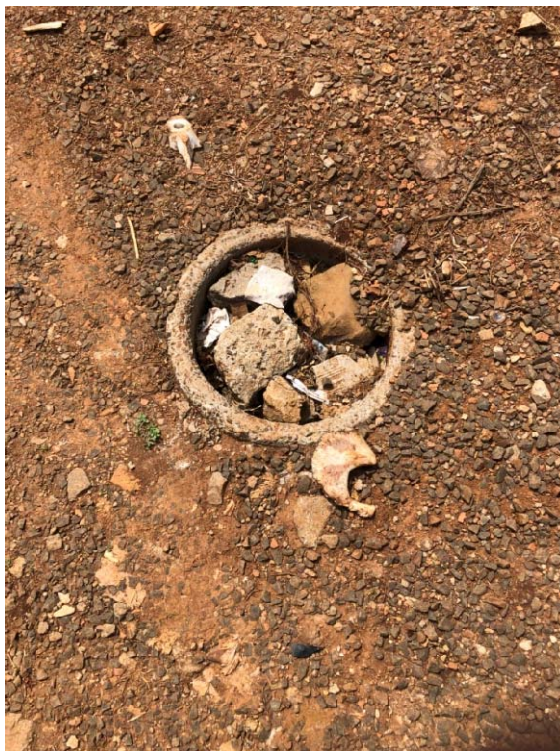
Fotos 03 á 06: Situação de alguns PV's - totalmente obstruídos.
