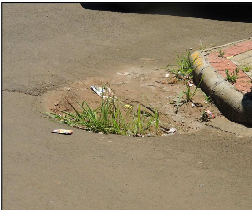
**Figura 59: Acúmulo de sedimentos – falha no sistema de drenagem urbana.**
