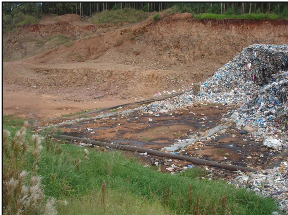
**Figura 38: Sistema de drenagem de líquidos percolados**
